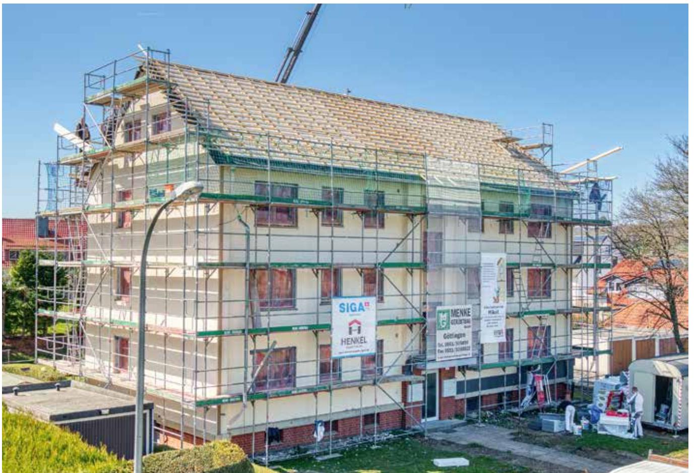
Modernisierung Lenglerner Straße 68
